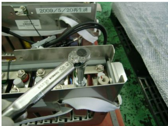
トルクレンチにて締め付け確認
